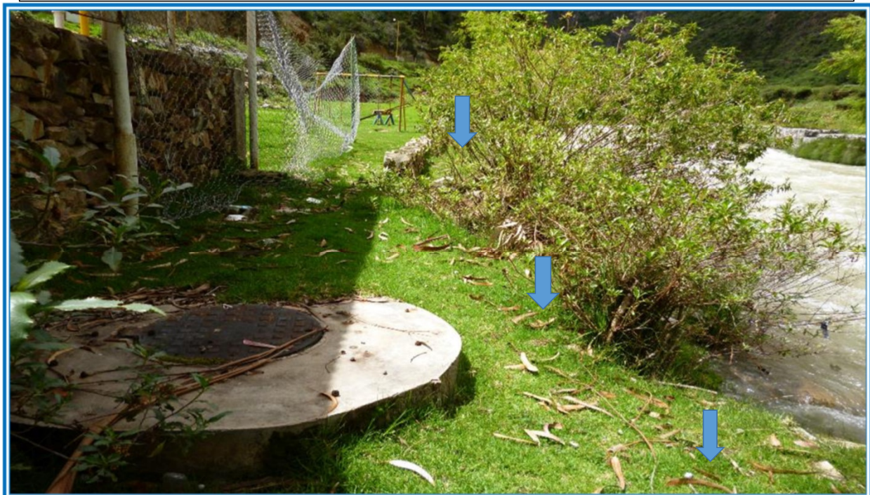
FIGURA N°03: SE OBSERVA LA MARGEN, DONDE EN UNA CREDIDA AFECTARIA EL SISTEMA DE ALCANTARILLADO.
